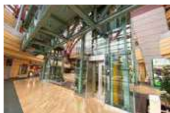
アトリウムエレベーター
