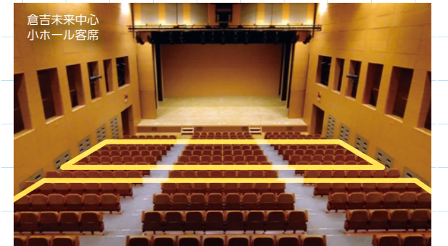
イエローライン：客席の下に設置されたケーブルの位置 このケーブルで囲まれたエリアに磁界が発生
