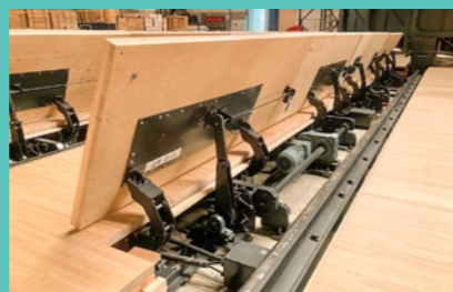
床下に隠れた走行レール
