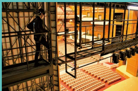
足場は高さ約10m。慎重に作業を進める
