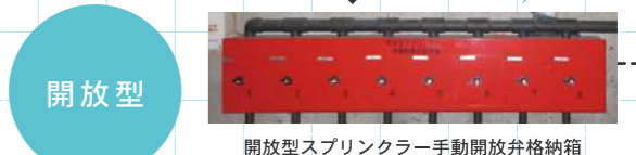
開放型スプリンクラー手動開放弁格納箱
